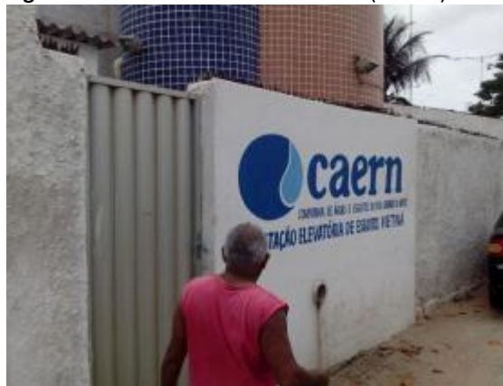
Figura 5. Vista da elevatória EE02-AS (Vietnã)
