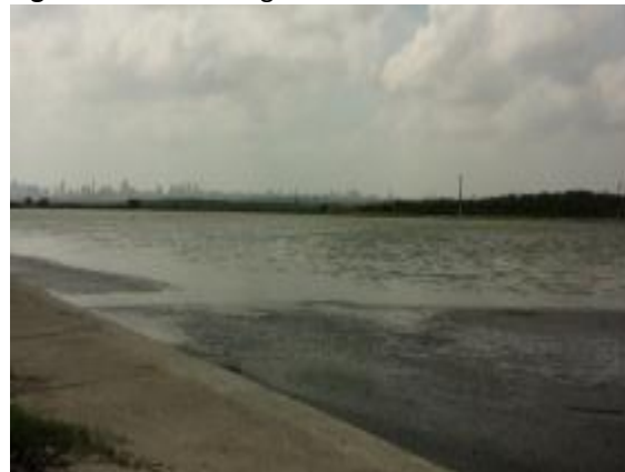
Figura 70. Vista da lagoa facultativa da ETE Beira Rio
