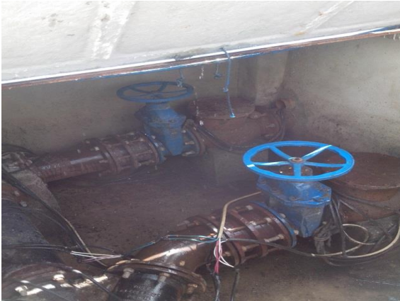
Figura 12. Vista do barrilete da elevatória EE01-GS
