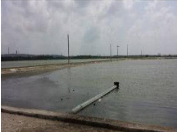
Figura 71. Vista da lagoa de maturação da ETE Beira Rio
