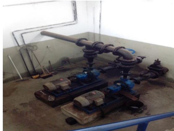
Figura 15. Vista das bombas da elevatória EE02-GS (D11)
