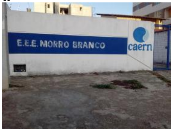
Figura 10. Vista frontal da estação elevatória EE01-GS
