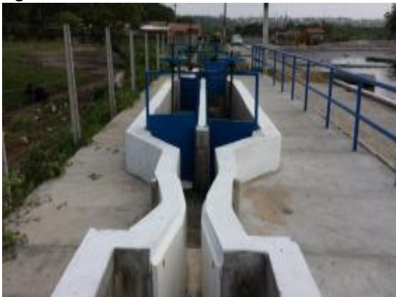
Figura 69. Pré-tratamento da ETE Beira Rio
