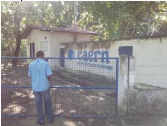
Figura 16. Vista da elevatória EE03-GS (Parque das Dunas)
