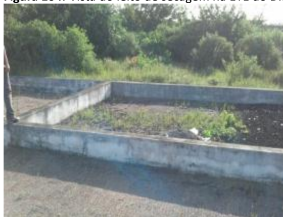
Figura 104. Vista do leito de secagem na ETE do DIN
