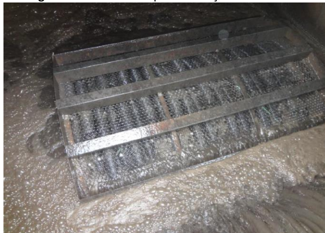
Figura 65. Vista do tanque de aeração com biodisco
