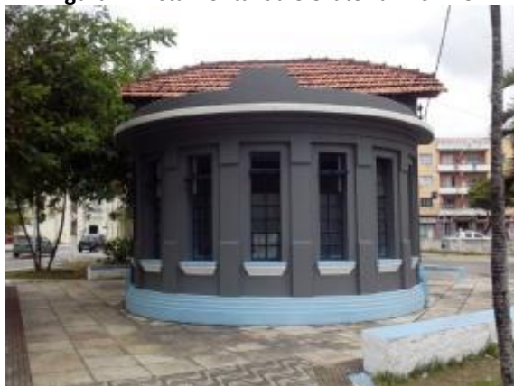
Figura 7. Vista frontal da elevatória EE01-B5
