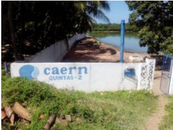
Figura 42. Vista da entrada da ETE Quintas II
