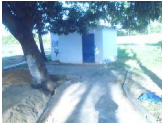
Figura 43. Vista da sala do operador da ETE Quintas II
