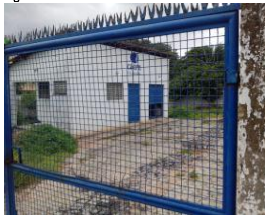
Figura 31. Vista frontal da elevatória EE02-NS
