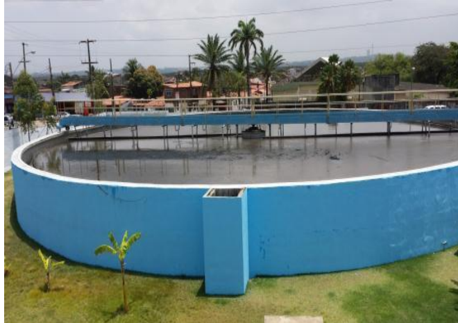
Figura 66. Vista do decantador secundário da ETE do Baldo
