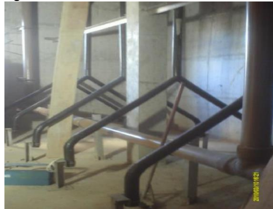
Figura 63. Vista interna dos reatores anaeróbios
