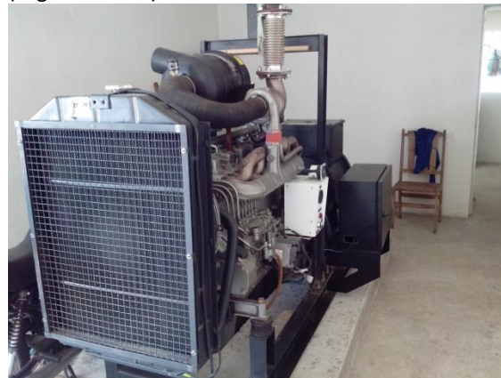
Figura 23. Vista do gerador da elevatória EE03-HS (Lagoa do Preá)
