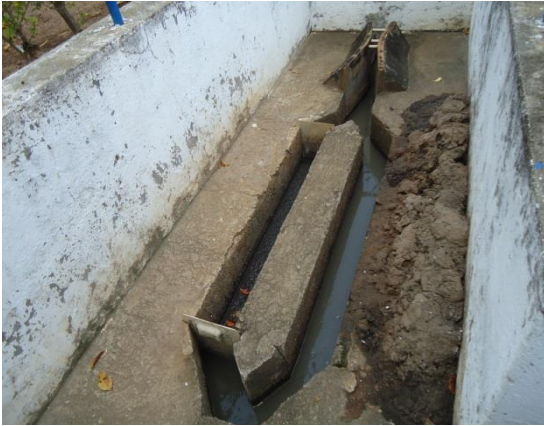
Figura 54. Vista da Caixa de Areia da ETE Tanque Imhoff
