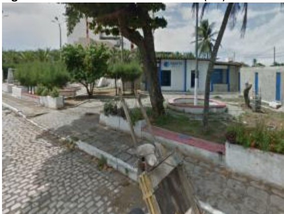
Figura 4. Vista da elevatória EE01-AS (D7)
