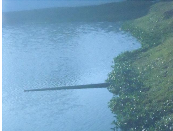
Figura 51. Vista da entrada de esgotos na lagoa de estabilização da ETE Bairro Nordeste
