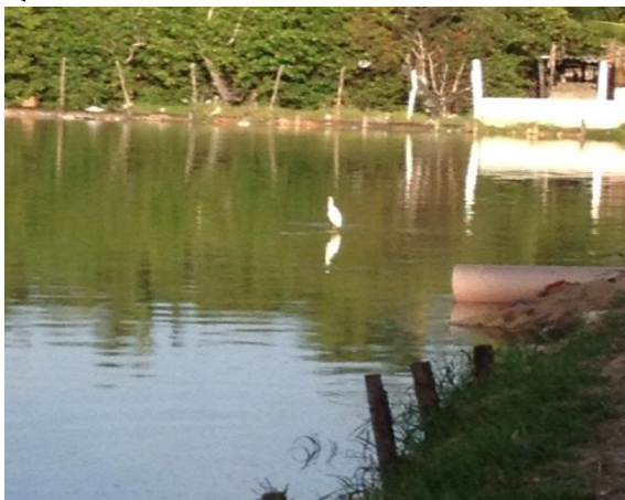
Figura 46. Vista do sistema de pré-tratamento ETE Quintas II
