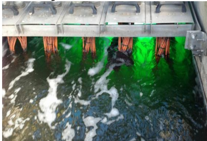
Figura 67. Vista do reator ultravioleta
