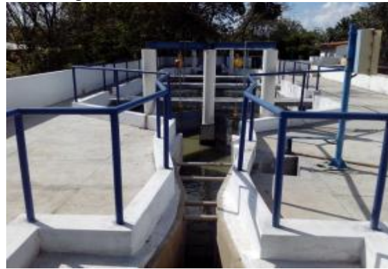
Figura 35. Vista do tratamento preliminar da ETE Ponta Negra
