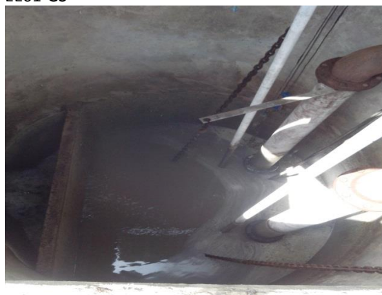
Figura 11. Vista do poço de sucção da elevatória da EE01-GS
