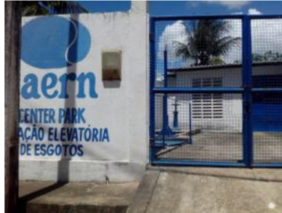
Figura 19. Vista da estação elevatória EE01-CP
