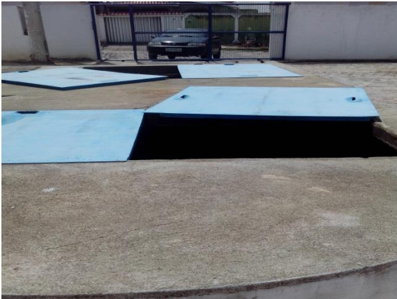
Figura 20. Vista da estação elevatória EE03-HS (Lagoa do Preá)
