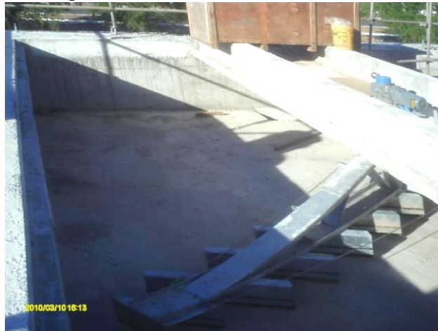
Figura 61. Vista da caixa de areia mecanizada
