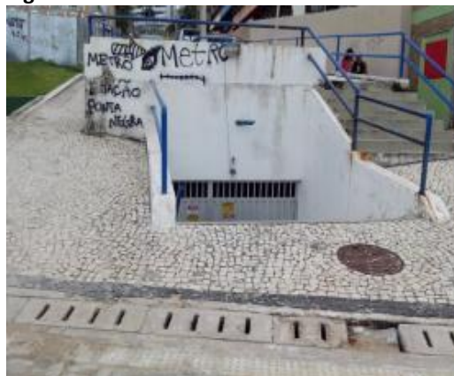
Figura 33. Vista da elevatória EE04-NS
