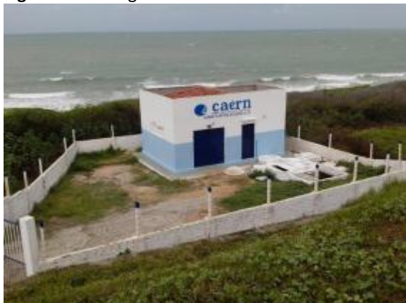
Figura 28. Vista geral da elevatória EEVC-03
