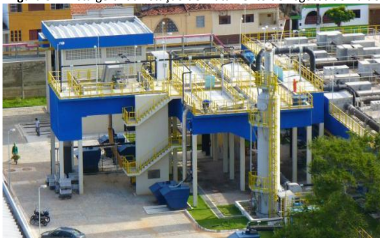
Figura 57. Vista geral da Estação de Tratamento de Esgotos do Baldo
