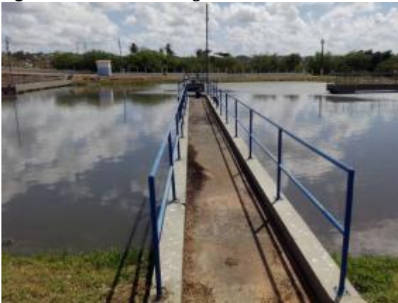
Figura 52. Vista da ETE lagoa aerada
