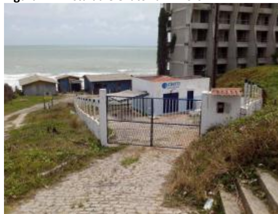
Figura 27. Vista da elevatória EEVC-02
