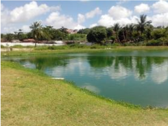
Figura 50. Vista da lagoa de estabilização da ETE Bairro Nordeste
