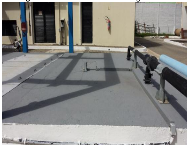
Figura 59. Vista da Elevatória de Esgoto Bruto
