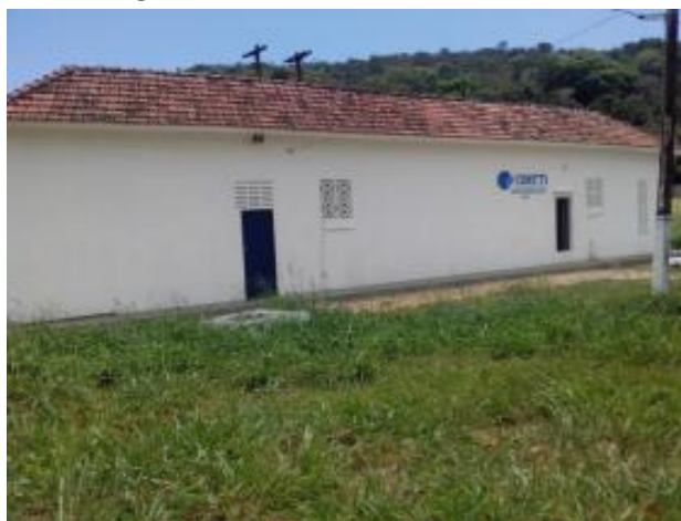
Figura 9. Vista da elevatória EE01-CS
