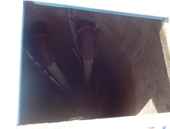
Figura 21. Vista do poço de sucção da elevatória EE03-HS (Lagoa do Preá)
