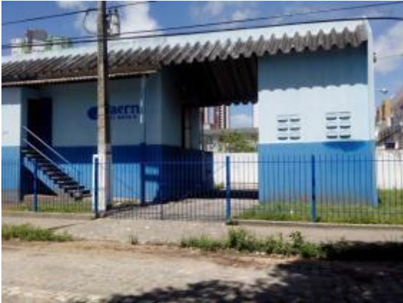
Figura 18. Vista da estação elevatória EE02-HS
