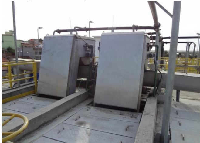
Figura 60. Vista do gradeamento fino mecanizado
