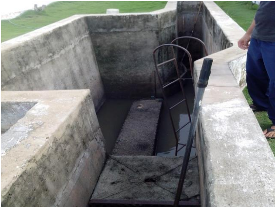
Figura 14. Vista do pré-tratamento da elevatória da EE02-GS (D11)
