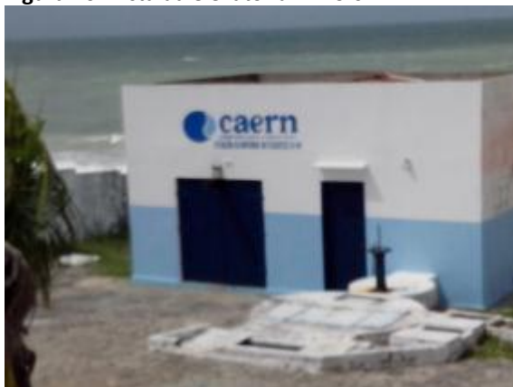
Figura 26. Vista da elevatória EEVC-01
