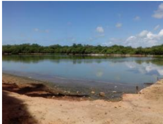
Figura 45. Vista da lagoa de estabilização da ETE Quintas II
