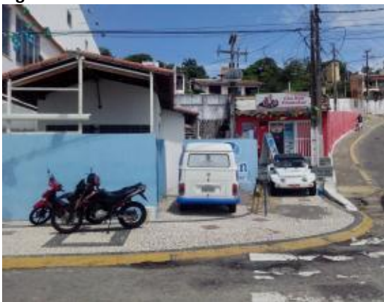
Figura 30. Vista da elevatória EE01-NS
