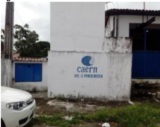
Figura 32. Vista da elevatória EE03-NS
