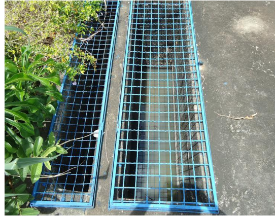
Figura 55. Vista superior do Tanque Imhoff
