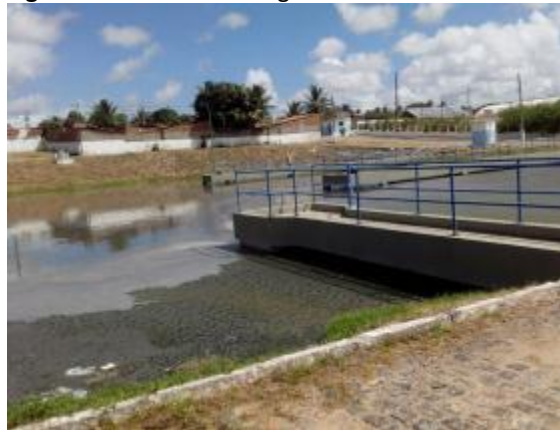
Figura 53. Vista da ETE lagoa aerada
