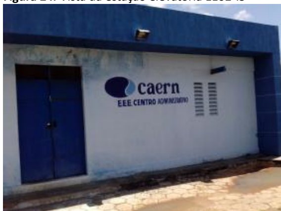
Figura 24. Vista da estação elevatória EE02-IS
