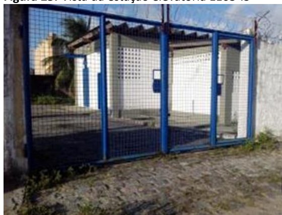
Figura 25. Vista da estação elevatória EE03-IS
