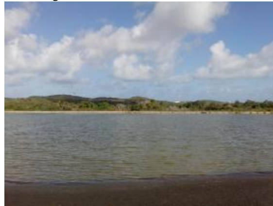
Figura 37. Vista de lagoa maturação da ETE de Ponta Negra
