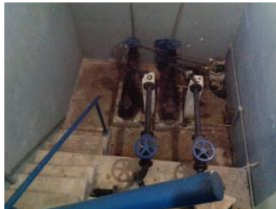
Figura 17. Vista das bombas centrífugas da elevatória EE03-GS
