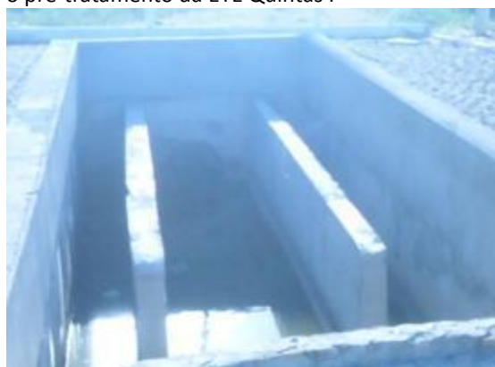
Figura 41. Vista da implantação de estação elevatória na área na qual outrora estava instalado o pré-tratamento da ETE Quintas I
