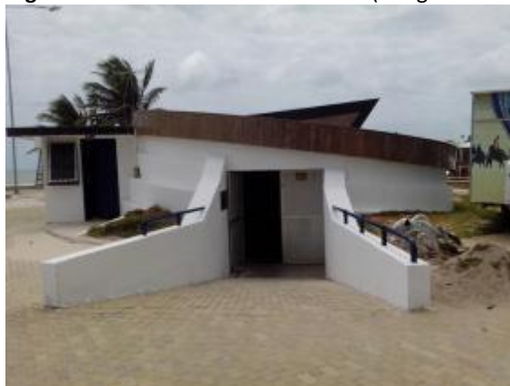
Figura 6. Vista da elevatória EE03-AS (relógio do sol)
