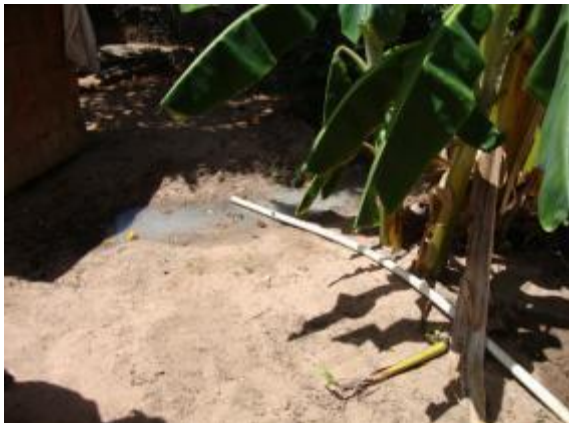
Figura 99. Vista de esgoto lançado em quintal de casa da Zona Norte de Natal
