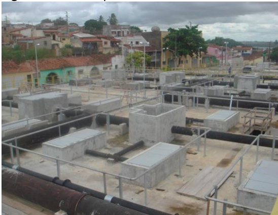
Figura 62. Vista Superior dos reatores UASB's
