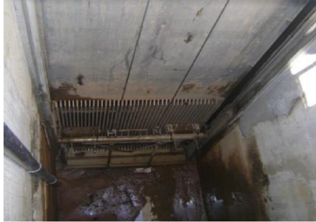
Figura 58. Vista do gradeamento grosseiro mecanizado
